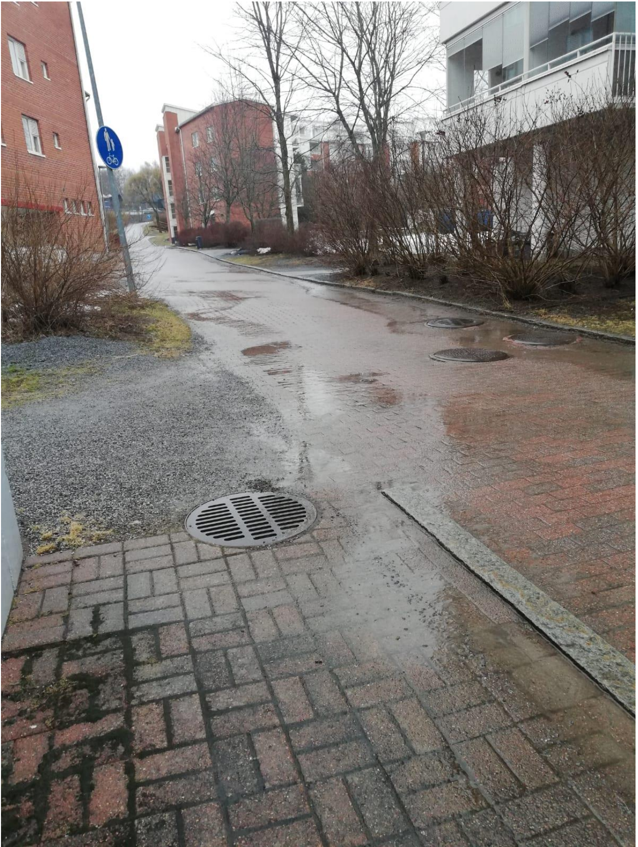
Kuva 2. Sulamis-ja sadevedet Haapalinnanraitti 2 talon pohjoiskulmalla, vedet virtaavat kaivon ohi
